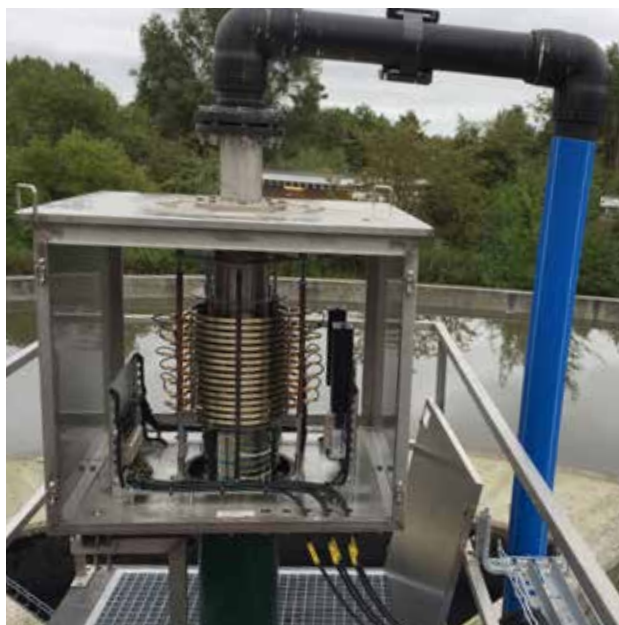
Unik og speciallavet slæbering med ubrudt vandrør igennem centrum.
